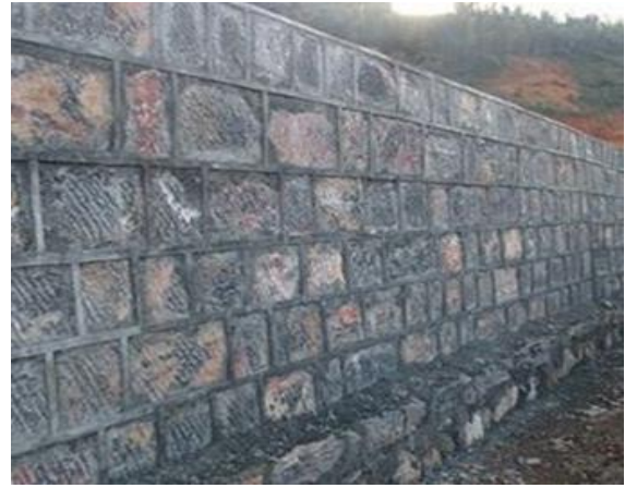
图 4 某工程的浆砌石墩墙
