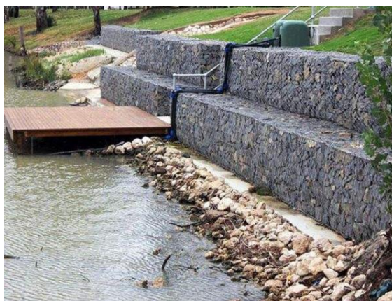
图 2 某河道台阶式网笼干砌挡墙
