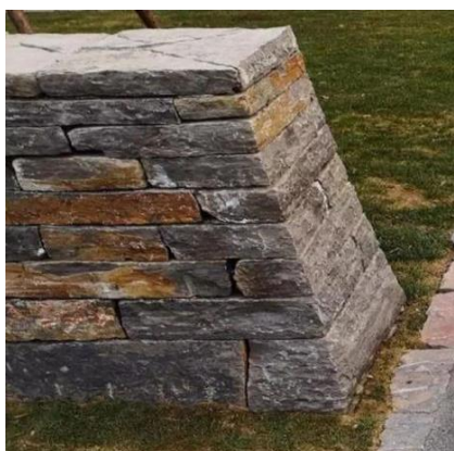
图 5 某工程的干砌石墙体
