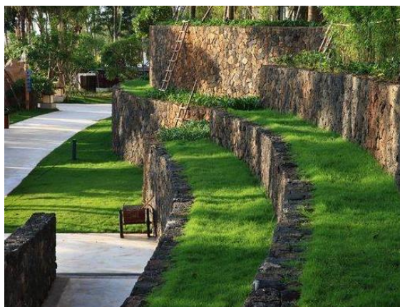
图 1 某工程台阶式浆砌石挡墙
