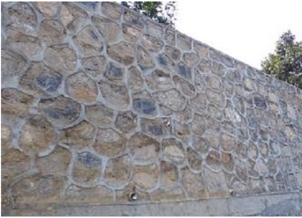
图 3 某工程的浆砌石墩墙
