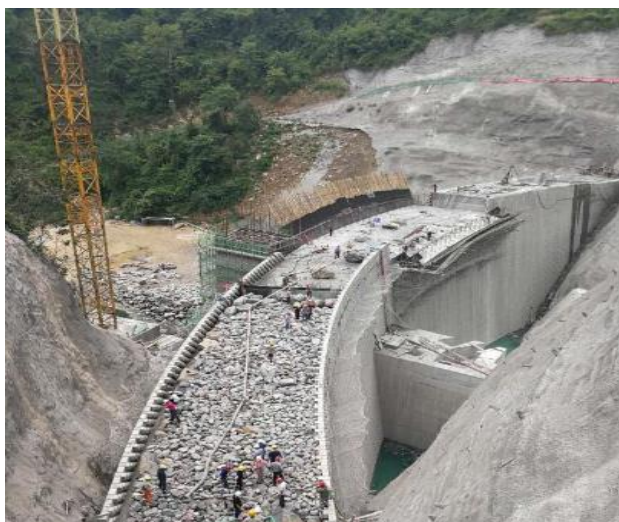
图 13 贵州绿塘水库坝顶灌砌施工
