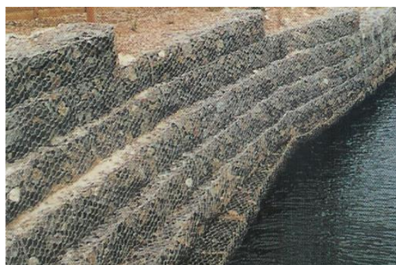
图 8 某工程的干砌石笼墩墙
