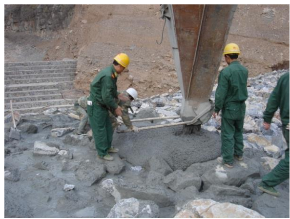
图 12 灌注自密实混凝土
