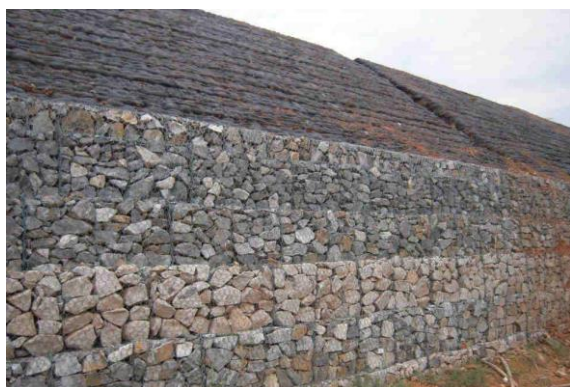
图 7 某工程的干砌石笼墩墙
