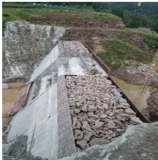
图 14 某工程坝顶灌砌施工
