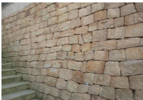
图 6 某工程的干砌石挡土墙
